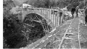
Construcció del pont de Mereig. Autor: J. Vehils. ANA
